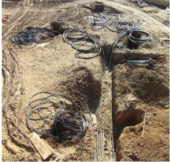
Instalación geotermia: tubos en pozos.
