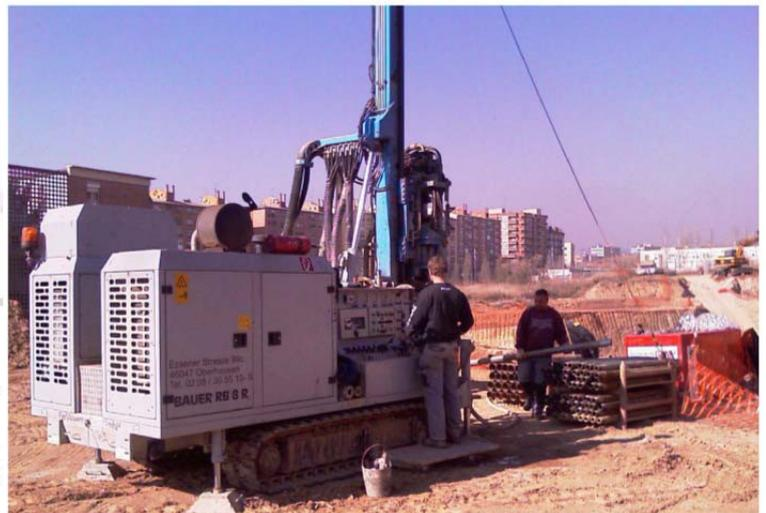
Instalación geotermia: perforación de los pozos.
