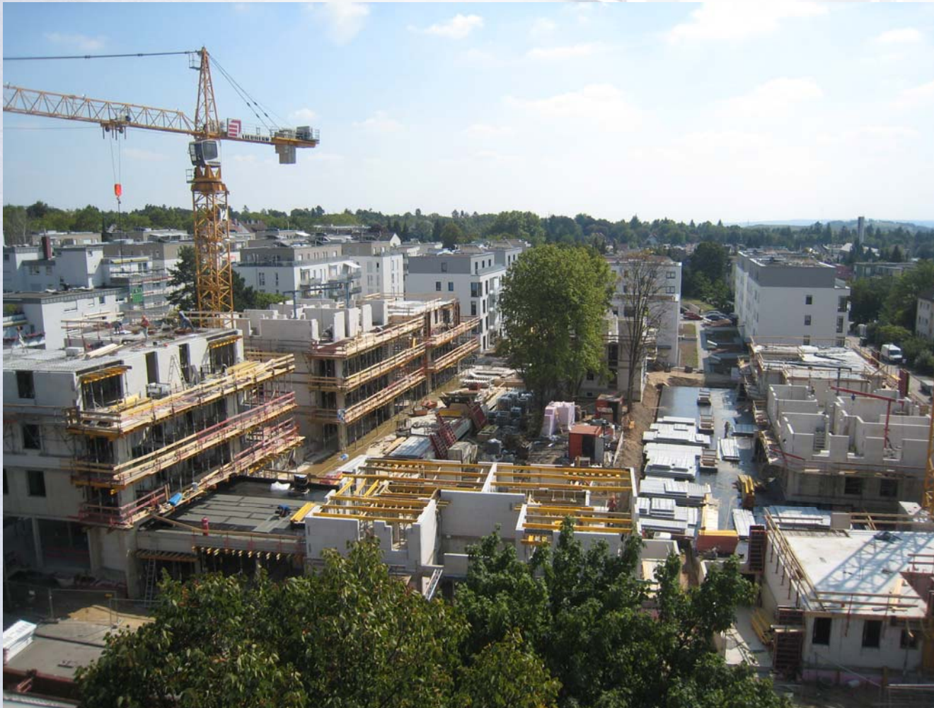
Blick von Nordwest in der Rohbauphase
