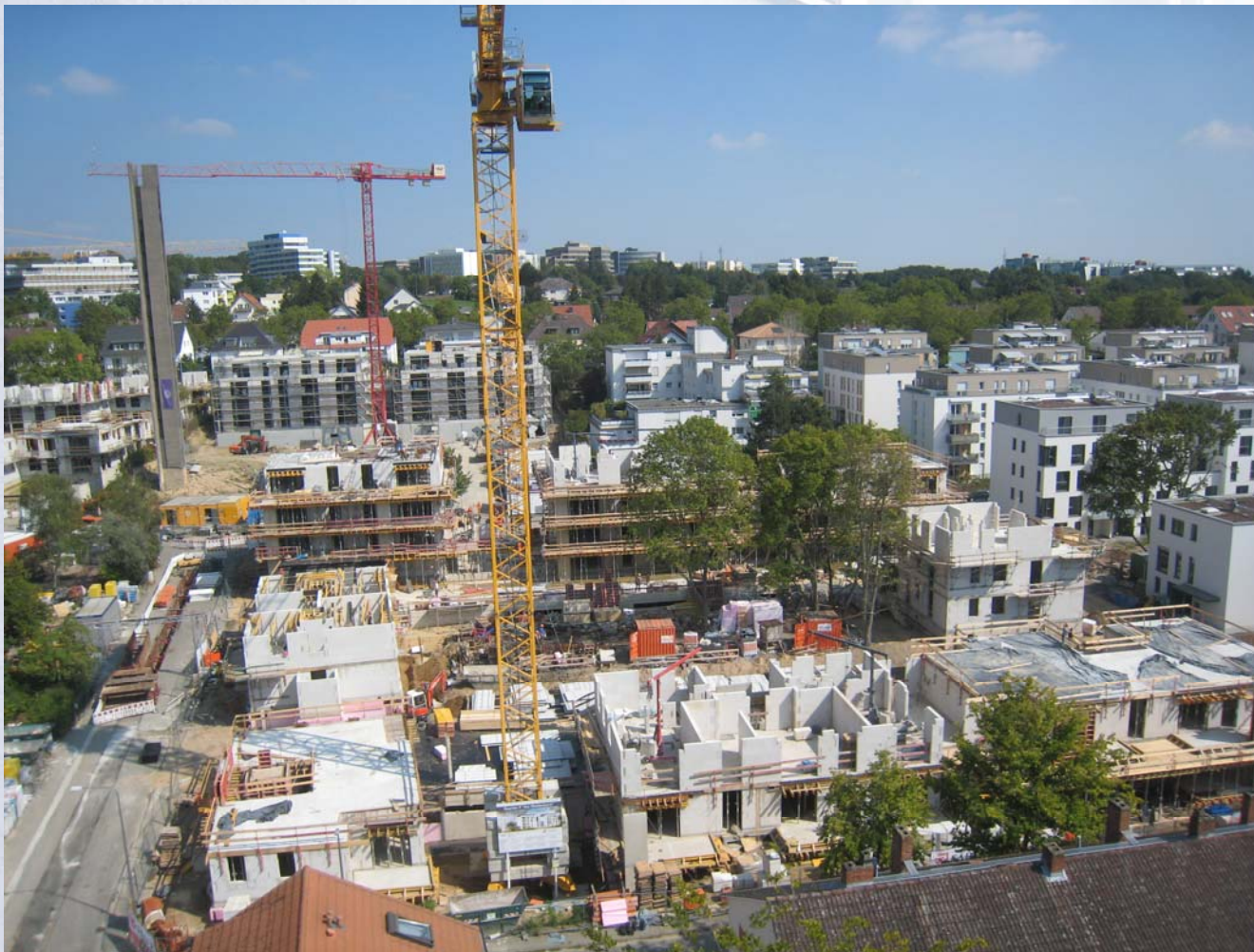
Blick Südwest in der Rohbauphase
